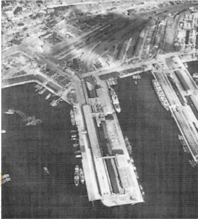
미국 보급품이 양륙되는 전쟁 당시 부산항 부두의 전경
