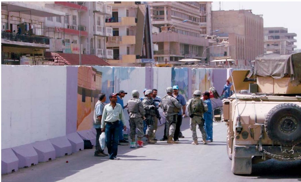
그림 20-5. 바그다드 안전방벽 설치
