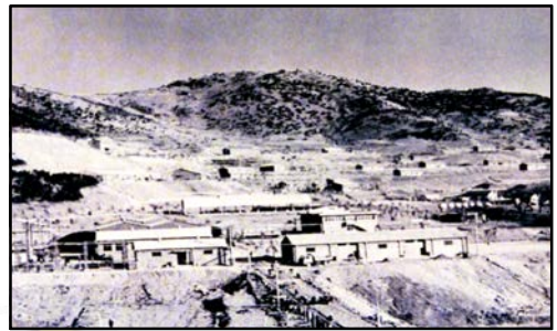
〈사진 4-10〉 M16 소총 생산공장 건설현장(부산시 기장군 철마면)
