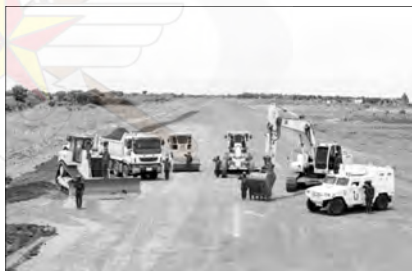
한빛부대의 보르공항 확장공사 모습 (국방일보 '23.4.14)
